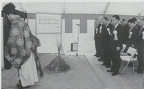
火葬場建設へスタート、地鎮祭の様子（9/9）
