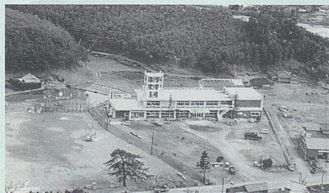
昭和41年頃の麻生町役場新庁舎
