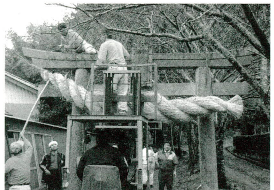
吊り下げるのにも一苦労
