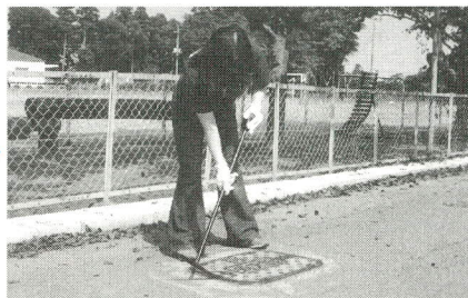
② 大箱回しのボール状の先を差込み消火栓のふたをゆるめます
