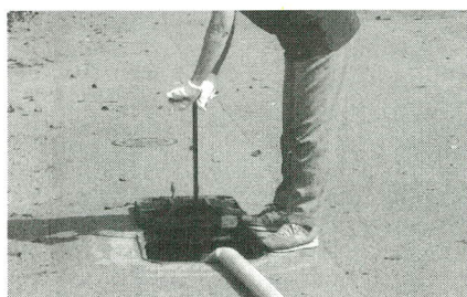
⑩ 筒先を確認し、ゆっくりと大箱回しで栓を開きます
