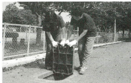
③ 消火栓ののっぺ部分を引き上げふたを開けます (手足を挟まないように注意)
