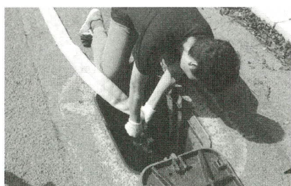
⑦ ホース先端のメス金具を消火栓に接続します
