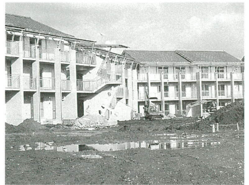
工事が進む新原北住宅
