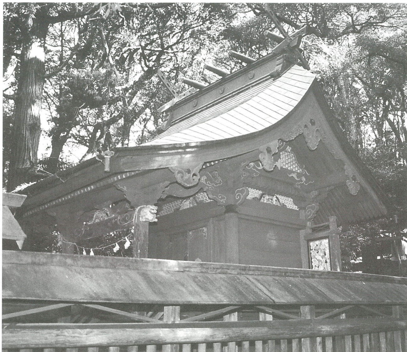
県有形文化財に指定されている熊野神社本殿。1394年に島並氏によって建立されたといわれています。1658年に焼失、翌年に再建されています。
