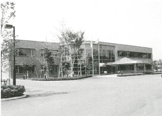
茶色を基調とした高さ9.95mの新麻生合同庁舎
