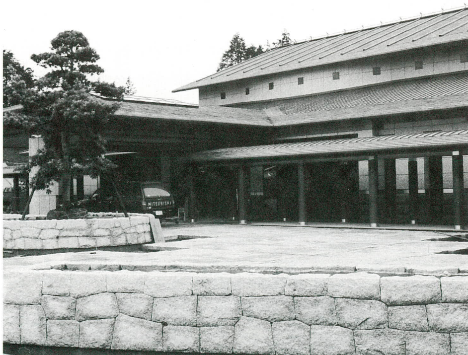
外構工事が終われば、完成です
