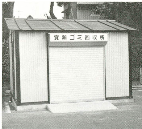
公民館に設置された資源ゴミ回収所
