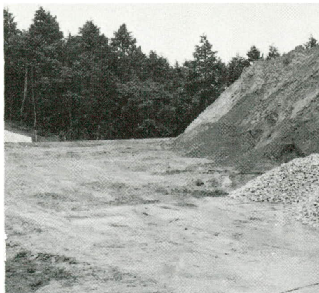
工事が進む広域火葬場
