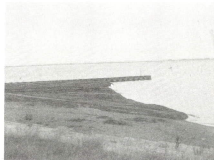
◀工事が始まった砂浜
