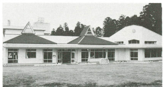
大和二幼の新園舎
