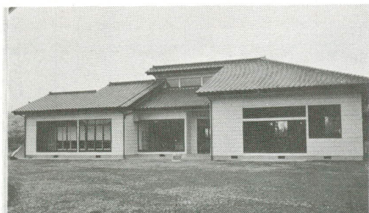
石神地区に建設された集落センター
