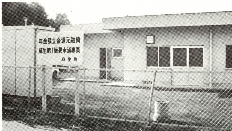
▼麻生第一簡易浄水場
