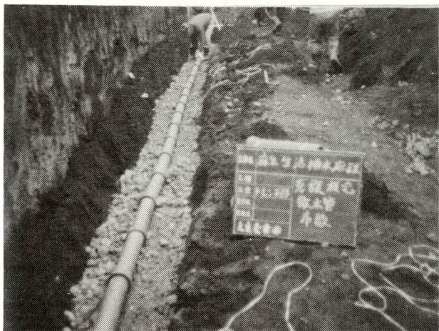
新見方式の生活雑排水処理 モデル施設の工事状況!!
