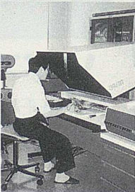
基本図の一つである、2万5 ▲図化機による製図
