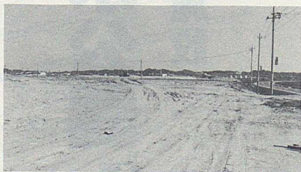
▲着工される「親水公園」現地
