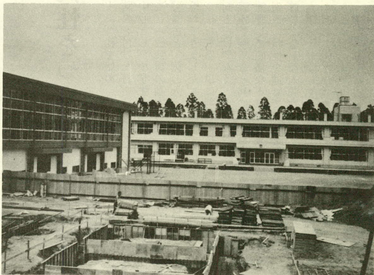
(大和二小) 屋内運動場、防音校舎 工事が進む、25メートルプール
