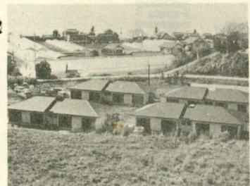
完成間近い町営住宅
