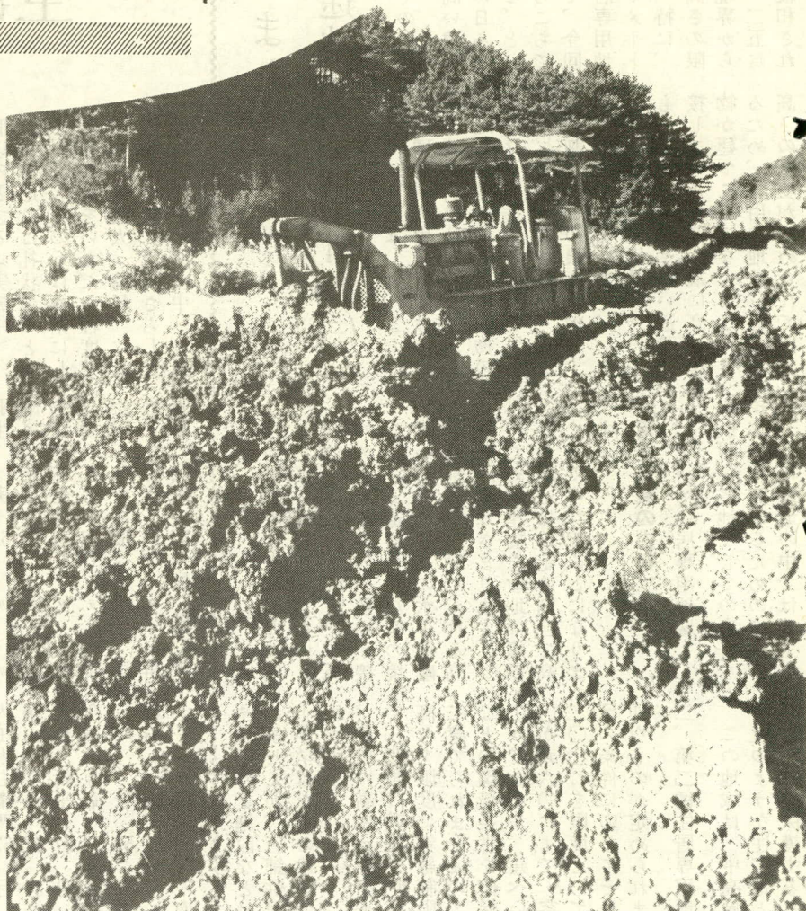
工事の進む町道大和二号線、蔵川にて
