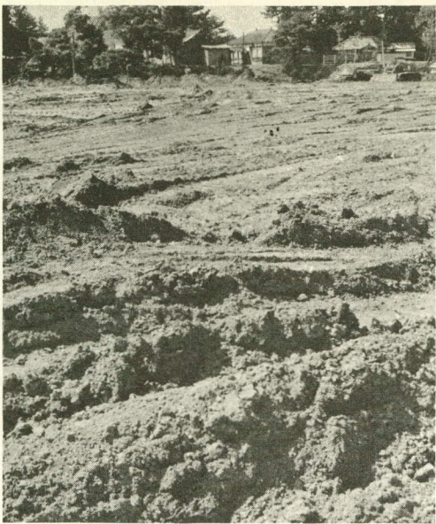
行方小学校敷地の造成工事 後方は現在の行方小学校
