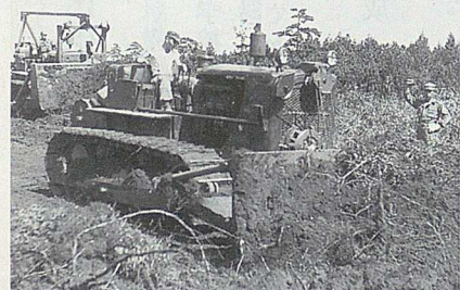
北浦中学校造成工事(昭和34年)
