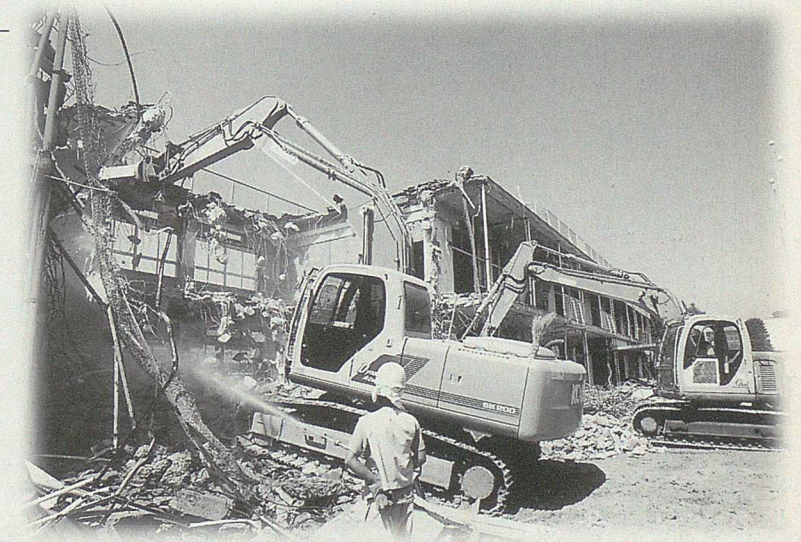
↑北浦中学校旧校舎の解体工事
