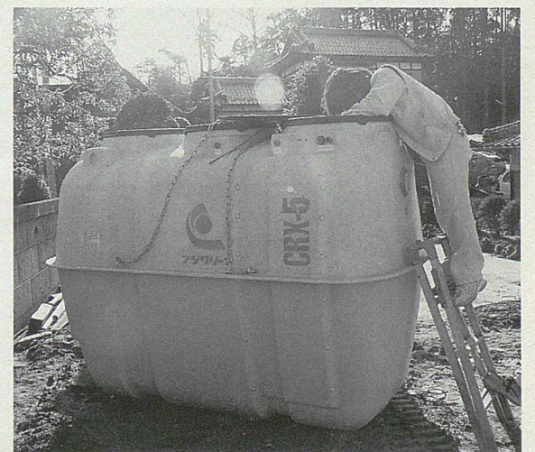
↑ 窒素・リンを処理できる高度処理型浄化槽
