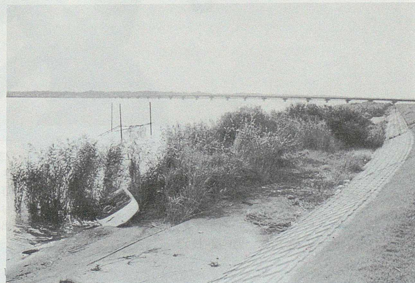
▼ 高須の護岸堤
