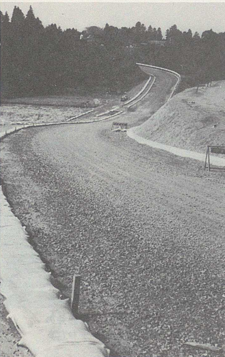
舗装される泉地内の町道
