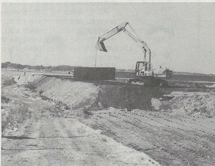
造成のすゝむ水の科学館（仮称）建設予定地
