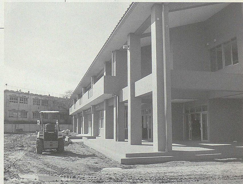
↑完成間近な北浦中学校校舎
