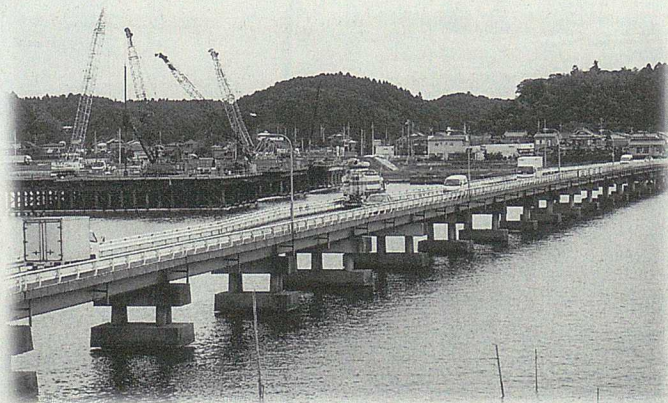
▲現在の鹿行大橋と建設中の橋（平成15年9月撮影）
