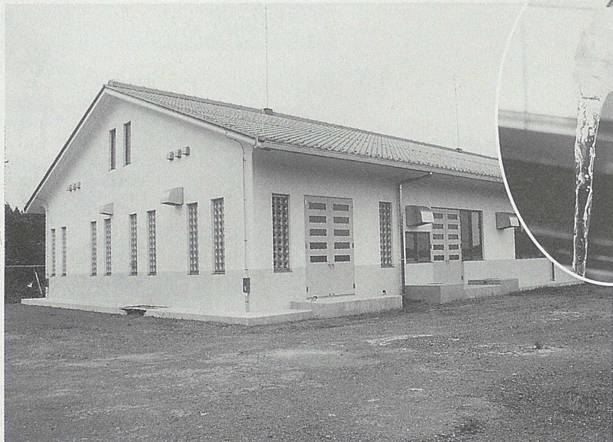
着々と工事がすすむ中央配水場（次木地区）
