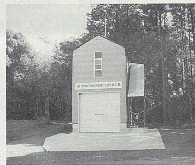
消防施設整備事業
