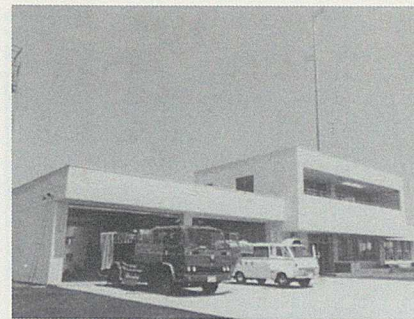
行方北部消防署完成 1976(昭和51)年
