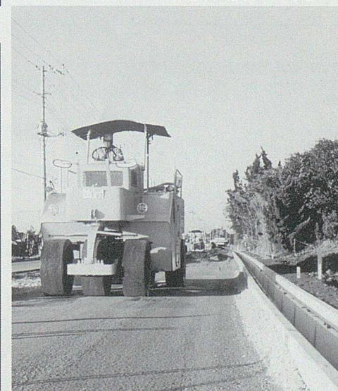
改良工事の進む町道102号線（小貫）
