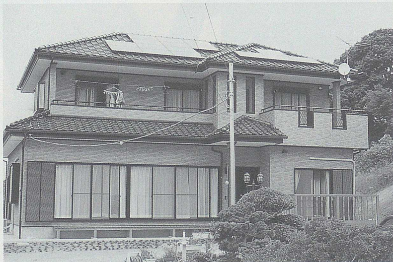
▲屋根に3.17kwの太陽電池パネルを配置
