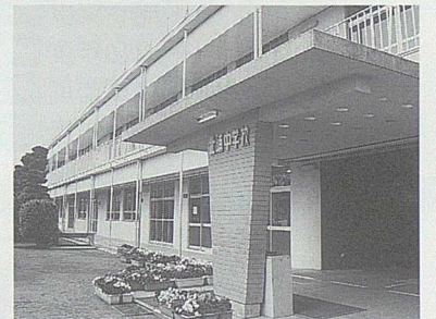
新校舎の建設が始まる 「北浦中学校」
