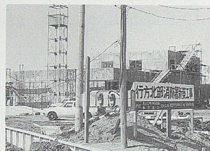
建設工事が進む行方北部消防署。同署ができる前は、「119番」をダイヤルすると役場につながっていました。
