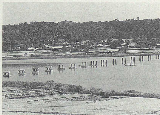
鹿行大橋の橋脚。右はしがこの年に就航した動力船の渡し。
