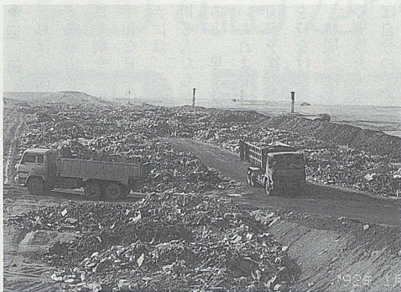
金浦ごみ処理場 埋め立て方式により、首都圏のゴミと全国の化学系の廃棄物を処理する。面積2,000ヘクタール、1日25,000トンが搬入される。発生するメタンガスは、冬の暖房に利用されている。ちなみにゴミのポイ捨ては、罰金100万ウォンだという。
