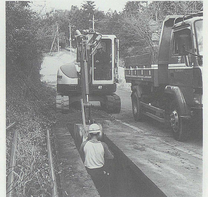
進む水道管敷設工事(小幡地内)
