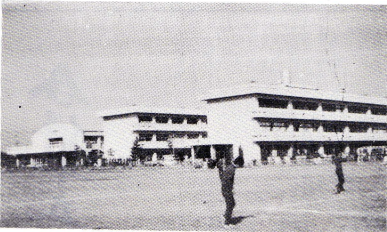
▲合併の象ちよう中学校 昭和39年3月から始まつた統合中学校建設工事は2年8カ月の日を費してその全部を終了、現在、美化も進められ学習体制は万全。
