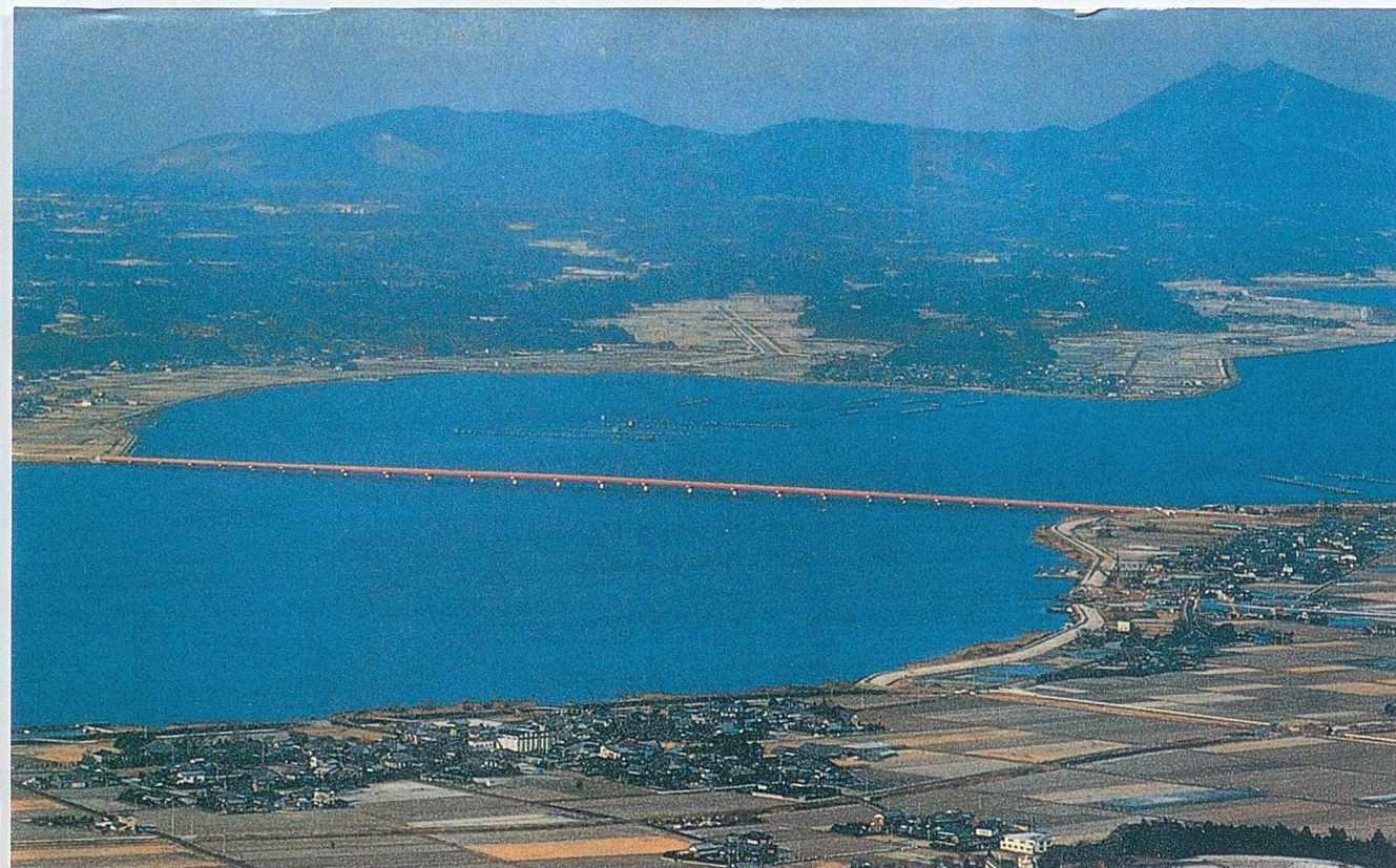
上空から見た霞ヶ浦大橋の全景
