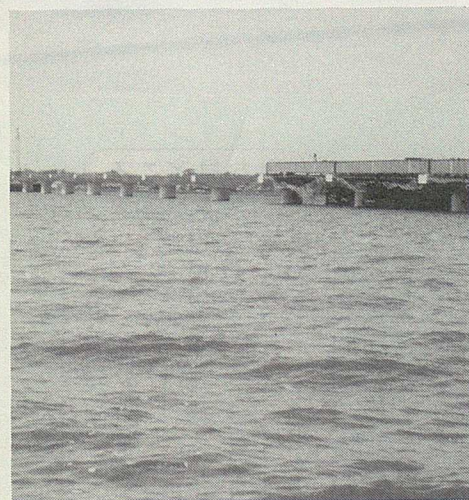
来年の春開通目ざし急ピッチで工事中の「霞ヶ浦大橋」
