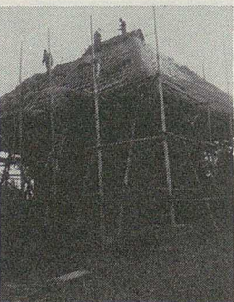
(上) 工事中の阿弥陀堂
