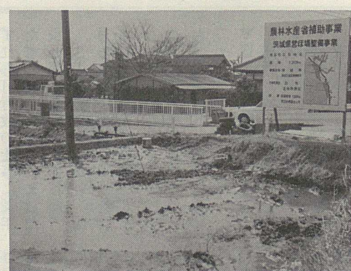
35ヘクタールの整地を行う立花地区のほ場整備
