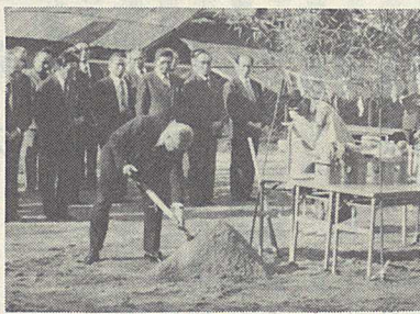
現地で行われた起工式の様子
