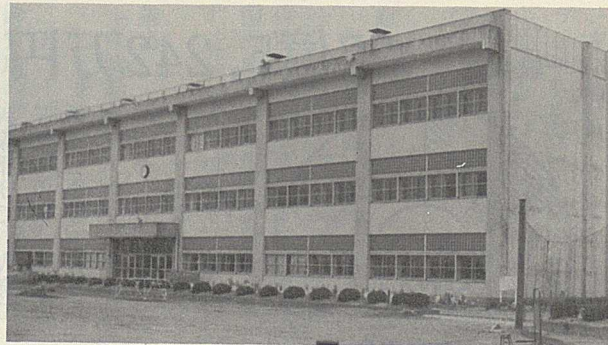
機能復旧工事をを行う玉造小学校舎
