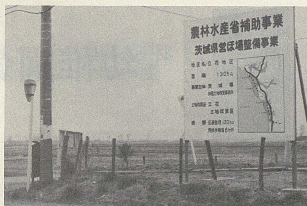
整地工事が行われる立花地区ほ場整備
