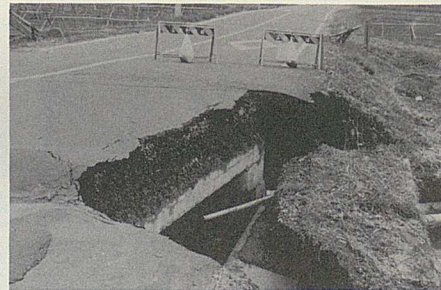
橋台の一部がくずれ落ちた現原二〇号線
