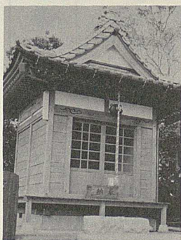
改築された観音堂
