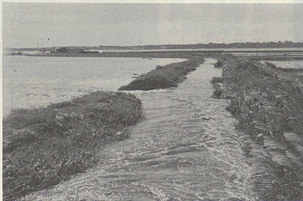
堤防が欠損した鎌田川(沖洲)
