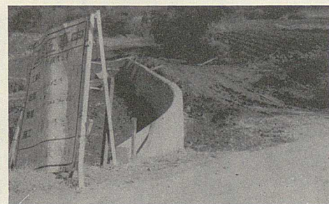
ことしも町道や農道を整備します
