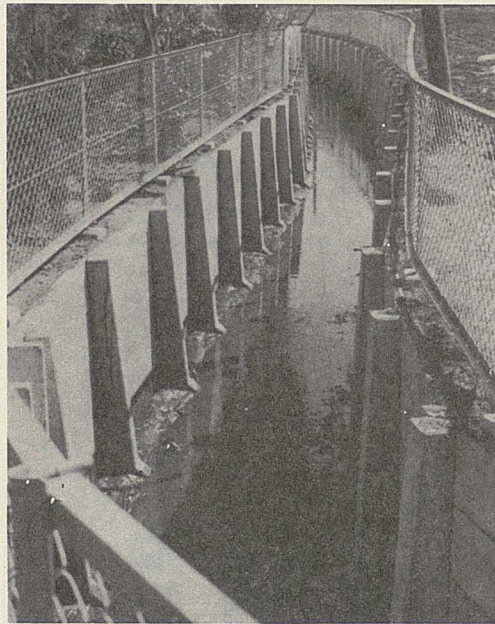
整備された排水路(新宿)
