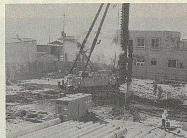
来年9月完成目ざして庁舎建設スタート(11月)
