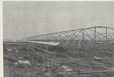
次々と建てられる鉄骨のハウス（谷島）
