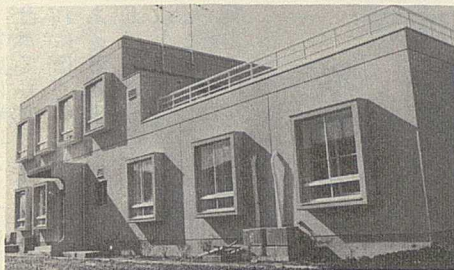
(写真) 完成した母子健康センターの全容
